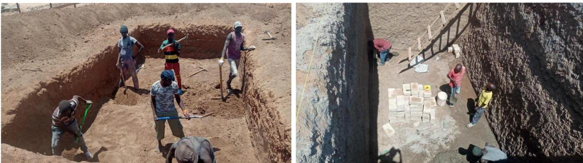
**Abb. 1:** Ausheben der Grube in 20 Fuß Tiefe
