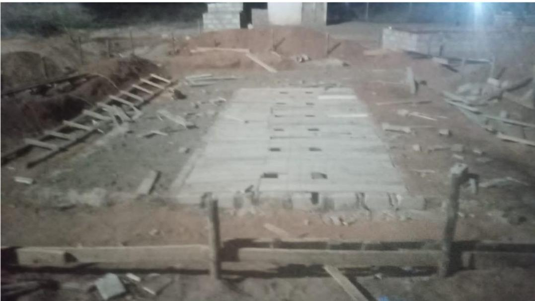
**Abb. 10:** Fundamentalschalung, die um den oberen Teil der Grube herum angebracht wurde, um Stahl und Beton zu halten
