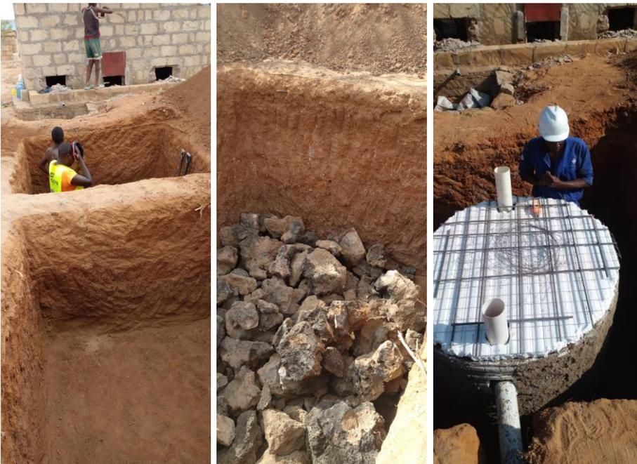
**Abb. 4:** Sickergruben und Sickerschächte vollständig ausgehoben, mit Steinen befüllt und mit einer biologischen Klärgrube versehen
