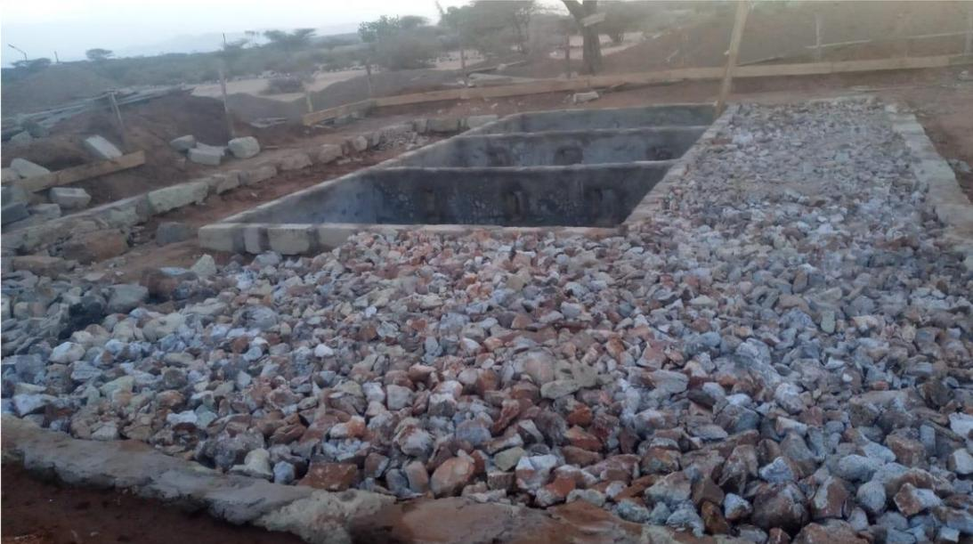
**Abb. 9:** Fertigstellung der Fundamentblöcke und Aufschüttung des Kerns
