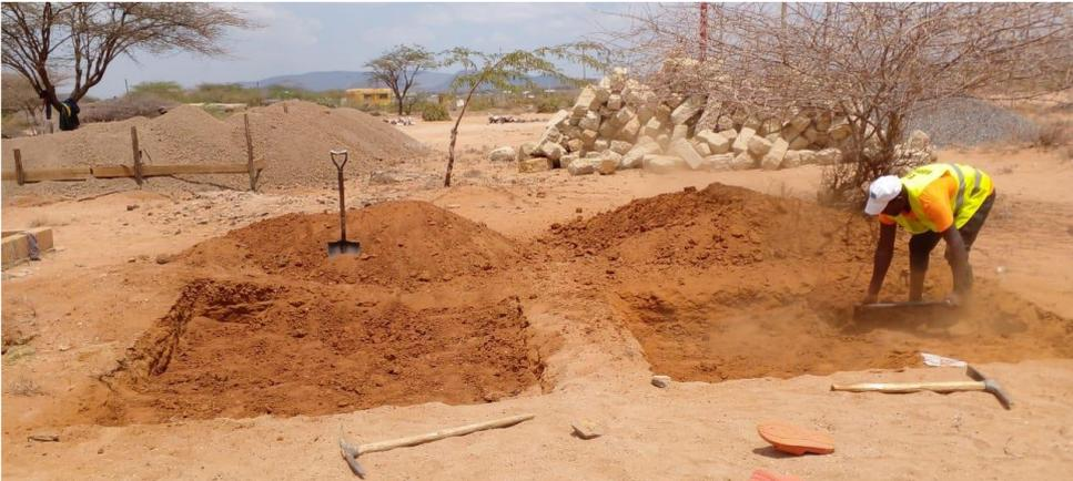
**Abb. 3:** Grabungsbeginn des Kanalisationssystems für Klärgrube und Sickergrube der Biokläranlage am 2. September 2022.
