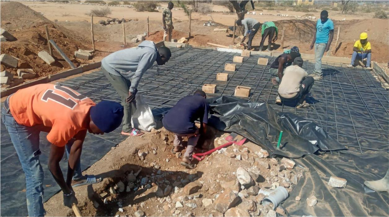
**Abb. 11:** Murram für die Verblendung aufgebracht, Anti-Termite auf das Murram gegossen, DPC-Material und D12-Stahl verlegt
