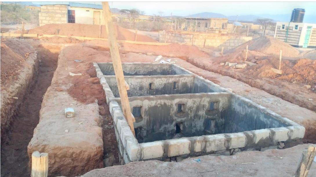
**Abb. 8:** Die Konstruktion der Innenwände hat das Bodenniveau erreicht, und es wurden glatte Oberflächen mit wasserdichtem Material aufgebracht. Auch der Unterbau des Projekts wurde rundherum ausgehoben.
