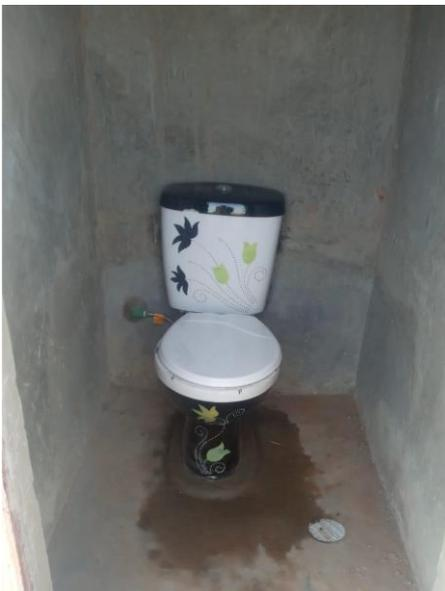
**Abb. 15:** Die Lehrertoilette. Die Reinigung der Oberfläche wird erfolgen, sobald der Zement, der die Toilette am Boden hält, getrocknet ist. Die Malerarbeiten an den Wänden werden gegen Ende des Hauptprojekts durchgeführt, um ein einheitliches Farbthema festzulegen
