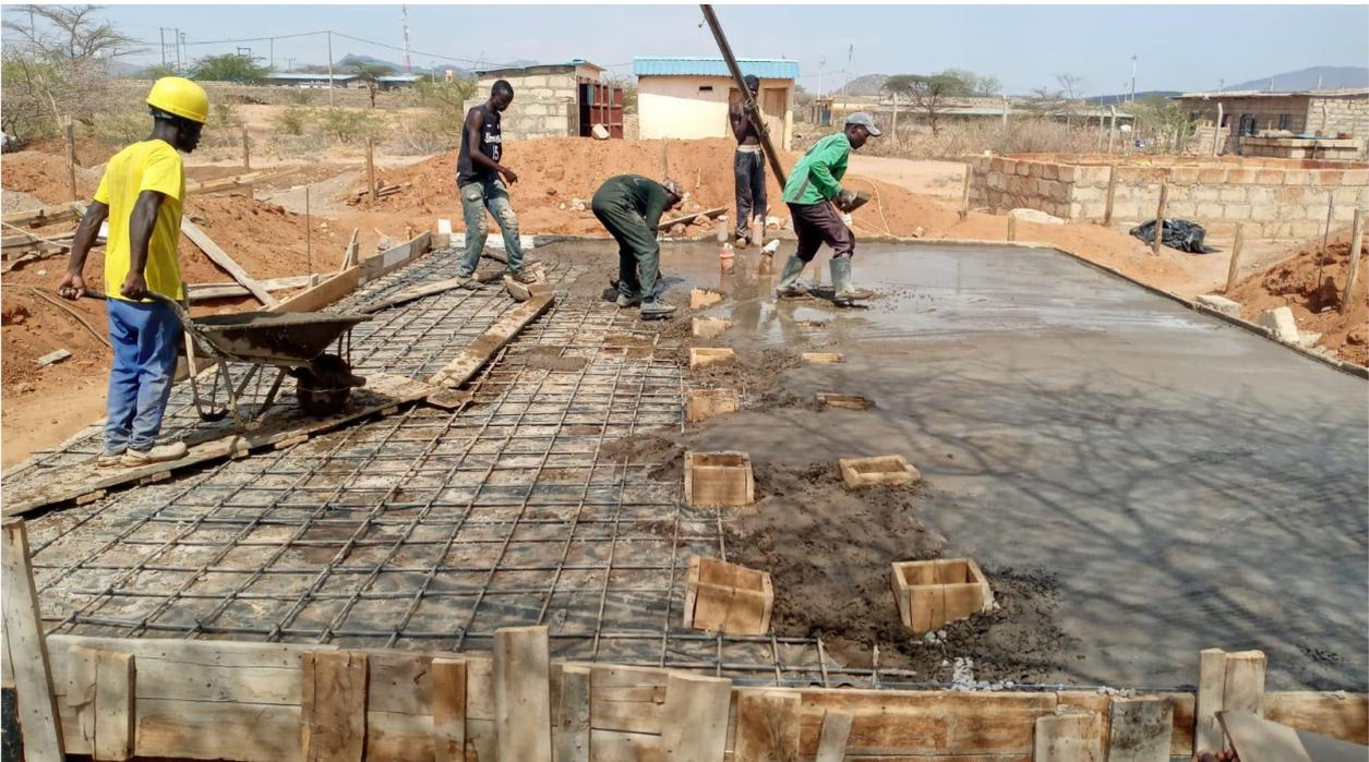
**Abb. 12:** Betonguss wird aufgetragen
