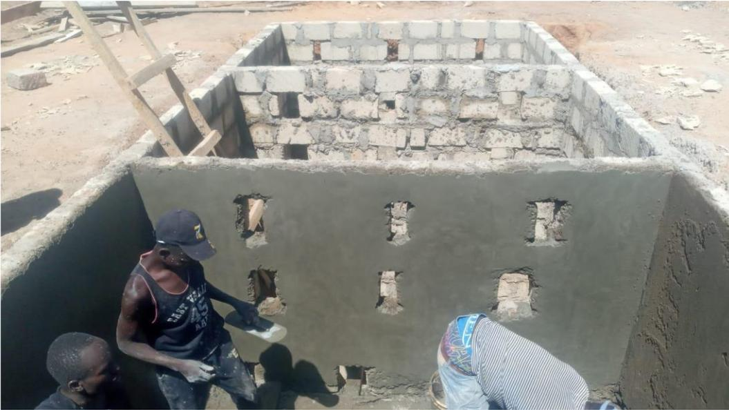
**Abb. 7:** Perforierte Trennwände verleihen der Struktur zusätzliche Stabilität
