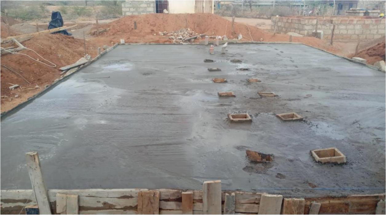
**Abb. 13:** Die Betonierung der Projektetage ist abgeschlossen und zeigt Platz für 12 lange Toiletten und auf der Ostseite 4 Plätze für Toiletten mit Wasserspülung
