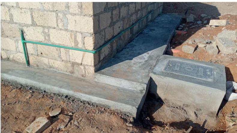
**Abb. 16:** Die Rohrleitungen und der Anschluss der Biokläranlage durch einen Schacht sind fertiggestellt
