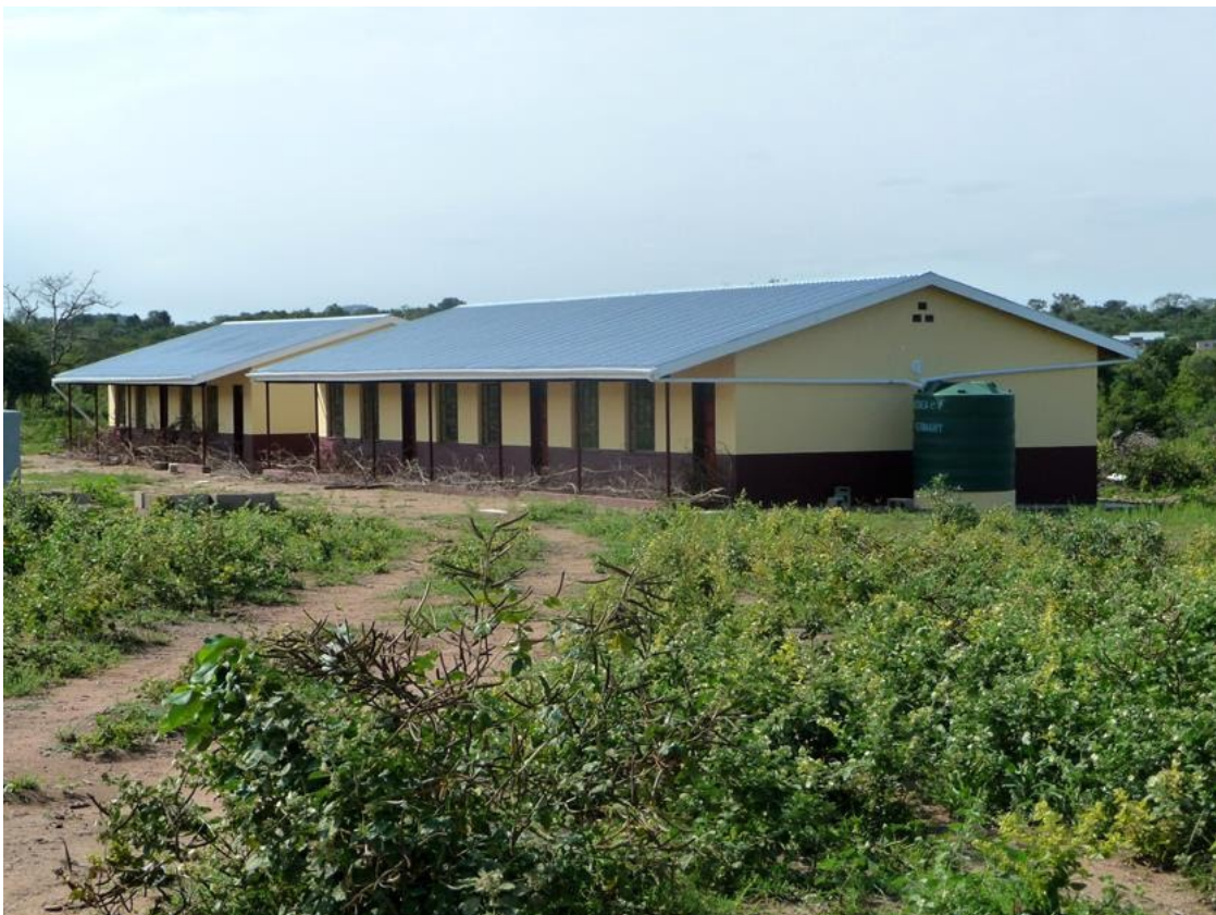
Bild oben: Fertigstellung der fünf High School Klassenräume (8.-12. Klasse)
